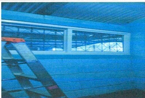
Foto 5: Mejoramiento de ventanas PVC
