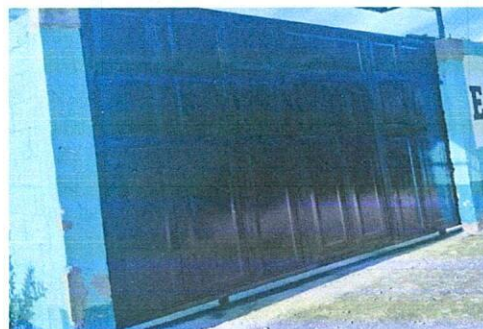
Foto 2: Mejoramiento del portón de metal de acceso a la escuela.
